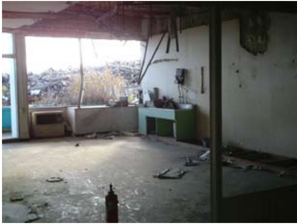
津波の被害に遭った請戸小学校の窓からは、ガレキの山の向こうに東京電力福島原発が見える。
